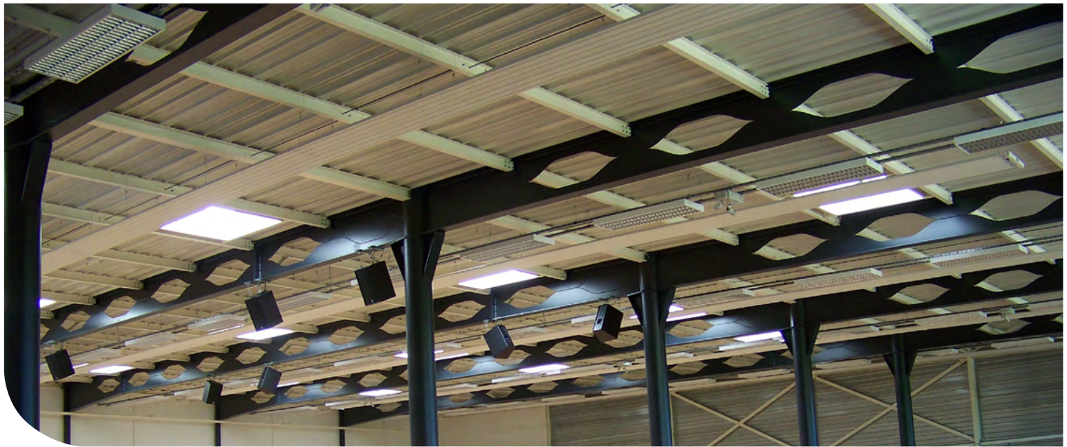
P. de Coubertin gymnasium (Bourges, France ; Arches Études)
